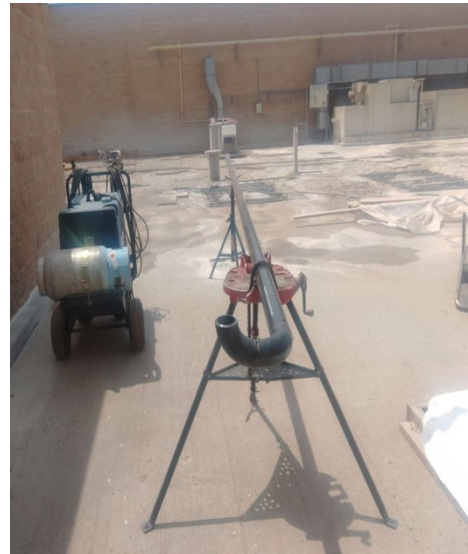
Ongoing fabrication of electrical conduit
