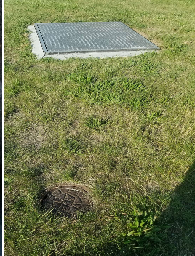
Inaccessible (Vault door locked)
