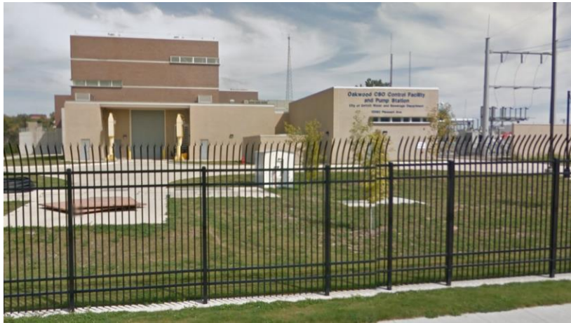
Figure VI-42. Oakwood CSO RTB
